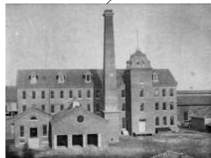
第二工場 明治22年(1889)竣工
