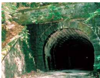
旧天城トンネル(天城山隧道)北口
