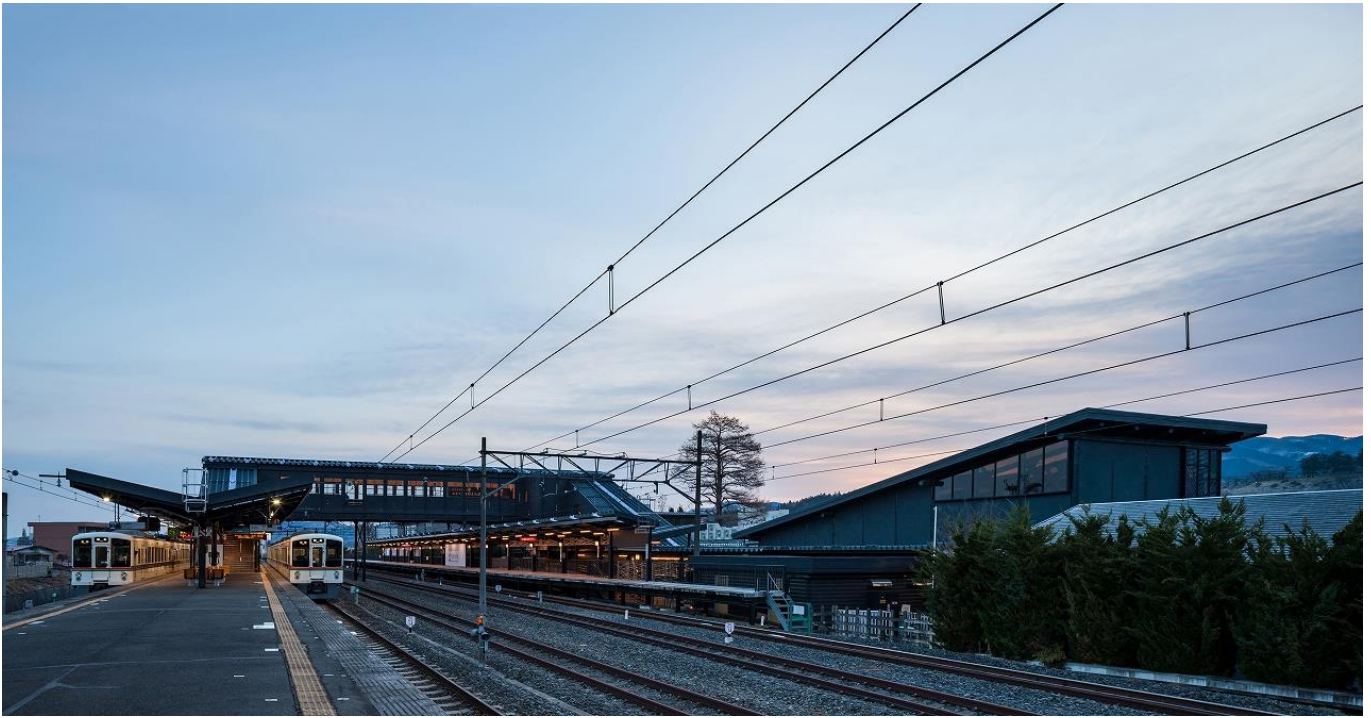
2・3番ホームから見た跨線橋と駅舎
