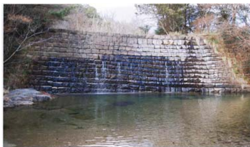
草津川桐生堰堤(オランダ堰堤) 本堰堤正面全景
