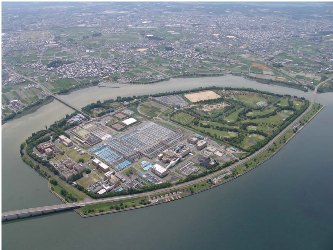
矢橋帰帆島（湖南中部浄化センター） H19年度撮影
