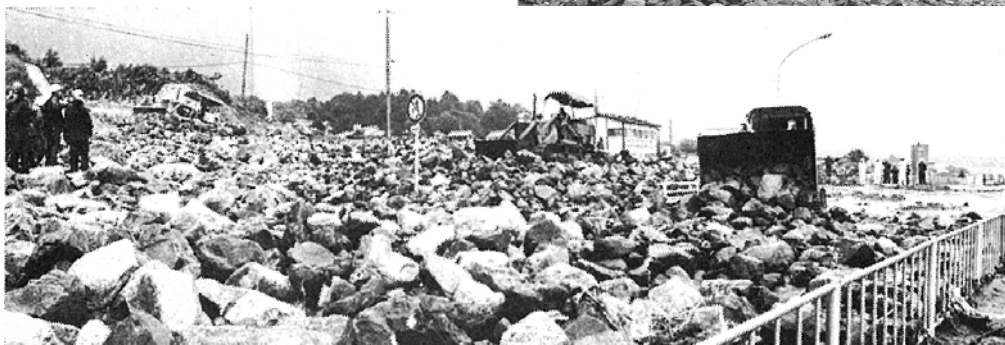
昭和50年台風6号により国道161号へ流出した土石流
