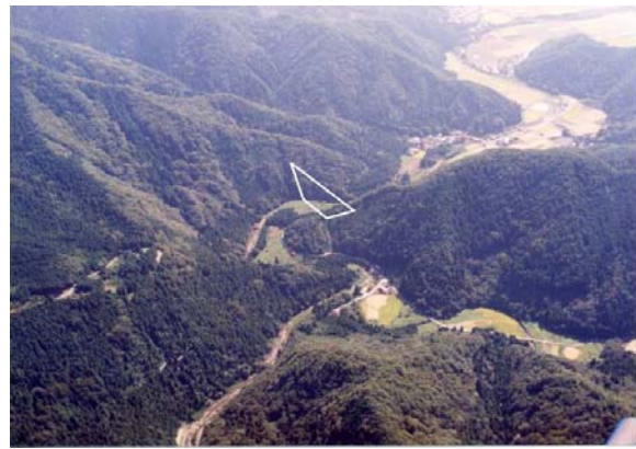
栗栖ダム、ダムサイト
