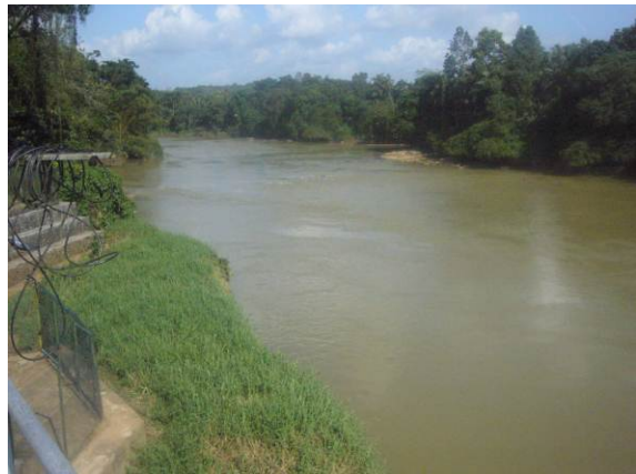
(写真) 取水口付近のカル河の様子
