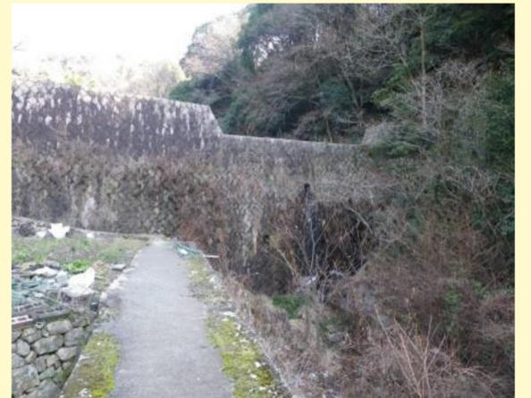
昭和25年建設: 堤高H=11.5m, 堤長L=50.0m
