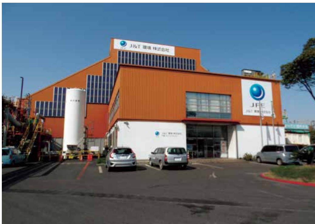
ガス化溶融施設の全景
