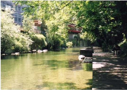
堀を近自然河川工法で改修した チューリッヒ市シャンチェングラーベン(平成2年)
