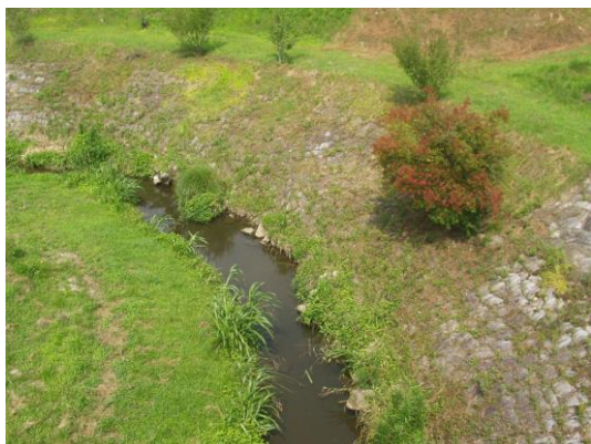
工事から 11 年後の太田川(平成 17 年)
