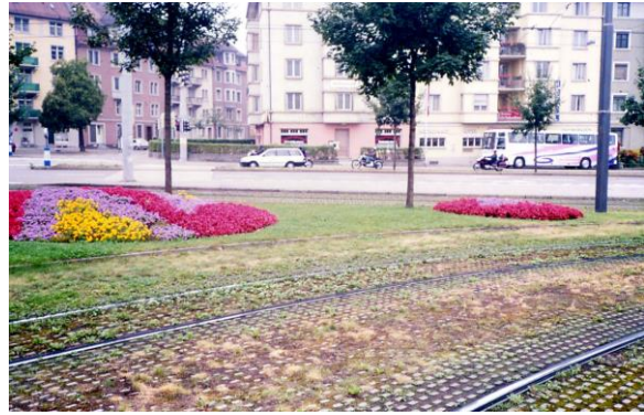
路面電車の軌道敷きも芝ブロックであった (チューリッヒ市、平成3年)
