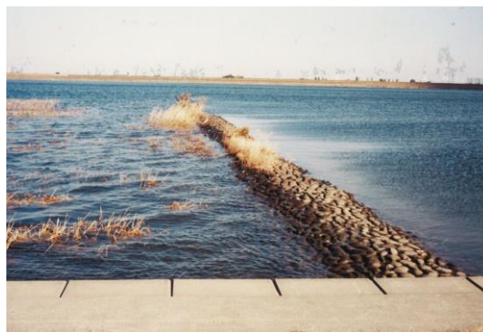
木曾川、長良川、揖斐川の河口にはデレーケが建設したケレップ水制が多い(昭和 63 年)
