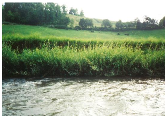
1年後には0.5m程度に生長していたレピッシュ川の柳柵工(平成3年)
