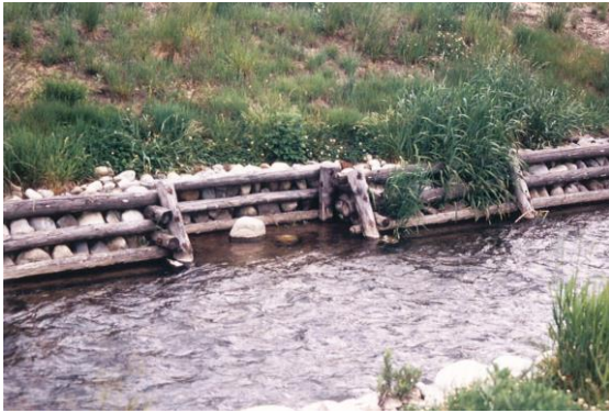
農具川の木工沈床護岸(昭和 62 年)
