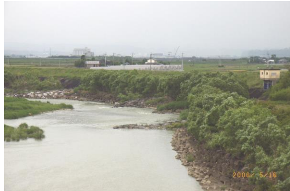
完成から 10 年経過後の球磨川・梅木地区(平成 18 年)
