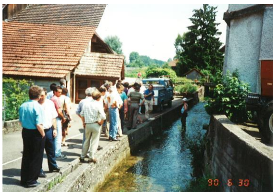
アピスト川の未改修区間はコンクリートで固められていた(平成2年)
