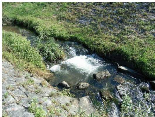
工事から 13 年後の太田川の落差工(平成 19 年)
