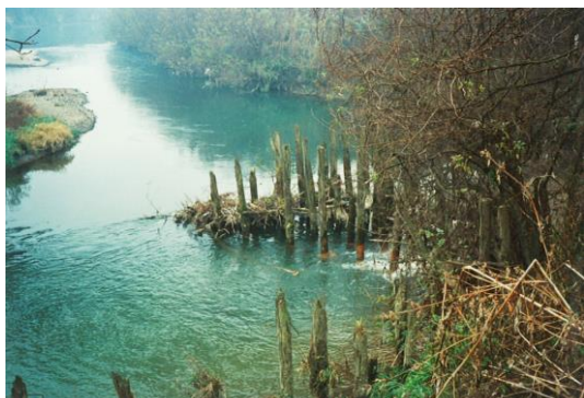
砂泥河川の千曲川には杭水制が多い(昭和 63 年)
