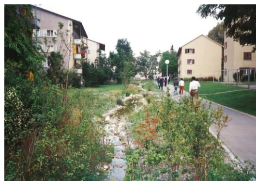
近自然河川工法で地下から復活したアルビスリーダー川(平成3年、チューリッヒ市)
