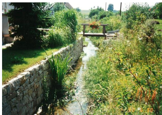
近自然河川工法で改修されたアピスト川(平成2年)
