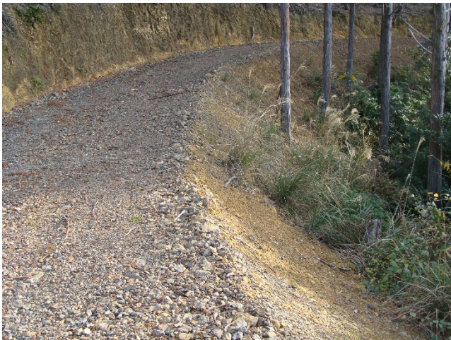
路面への現地発生材の利用例
