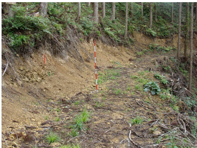
幅員確保のための崩土の除去
