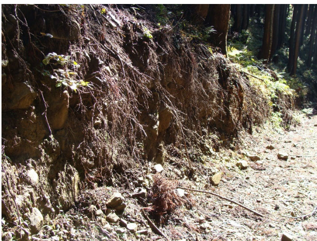
堆積岩質礫質土（砂岩）の切土のり面
