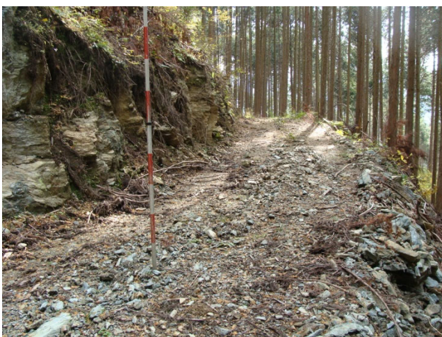
変成岩質礫質土(三波川変成岩帯)の切土のり面
