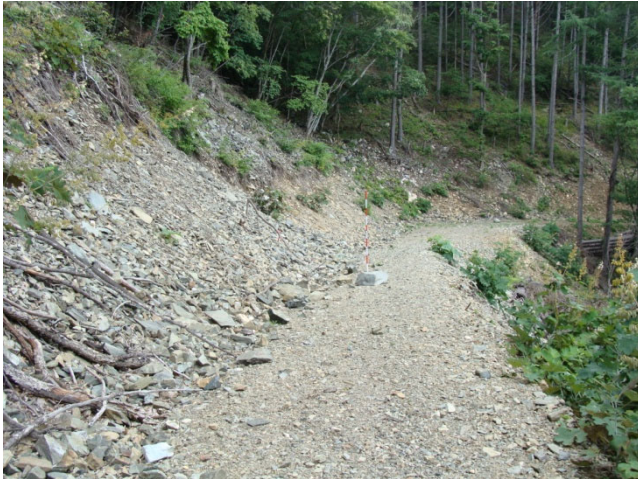
変成岩質礫質土の強度に変成を受けた切土のり面
