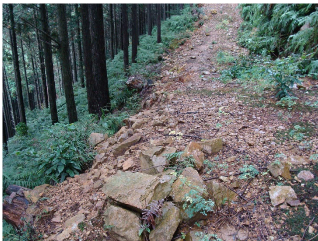
除去した崩土による路肩の強化
