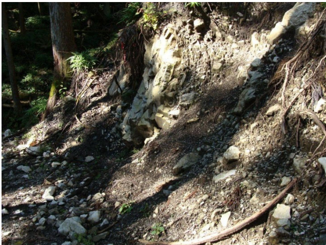
堆積岩質礫質土（秩父帯）の切土のり面
