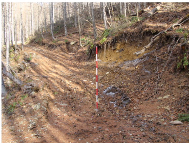
凍上融解によるオーバーハングの発生(ローム)
