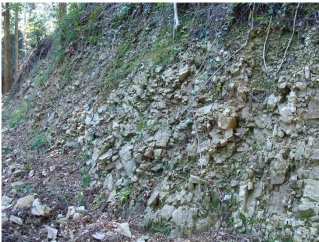
火成岩質礫質土(流紋岩)の切土のり面
