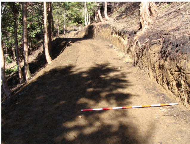
直切で施工したロームの切土のり面
