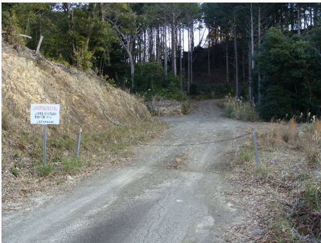
注意喚起看板を設けた一例
