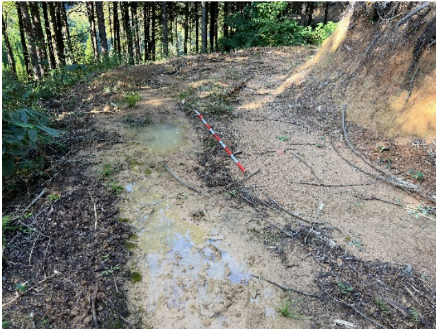
滞水の発生状況の例
