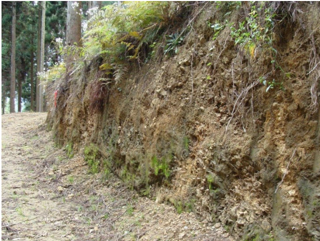
火成岩質礫質土(玄武岩)の切土のり面
