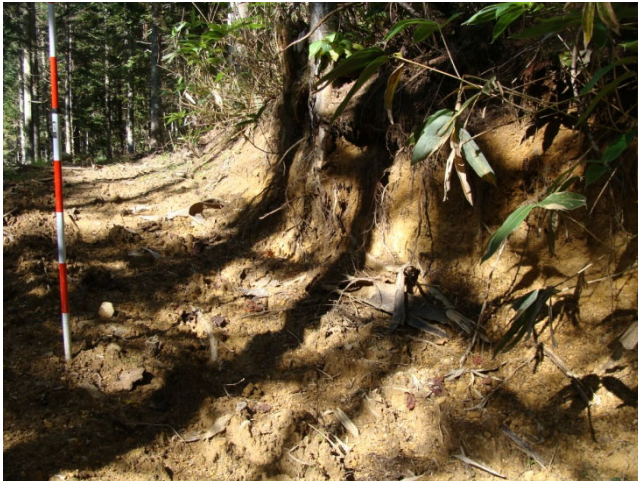
火山灰質粘性土の切土のり面
