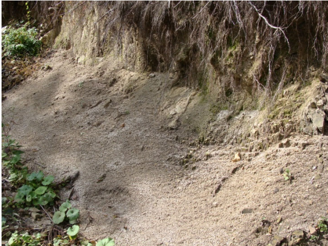
風化したまさ土ののり尻の堆積物
