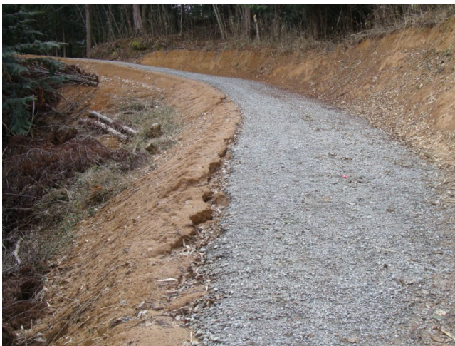
容易に侵食される粘性土とまさ土の混合土の状態
