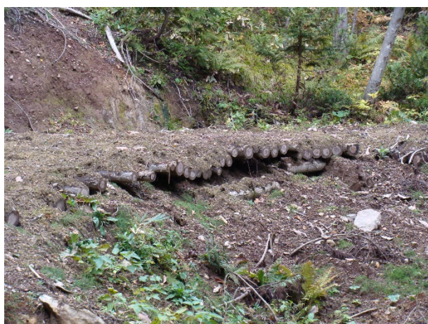
締固めが不足した丸太利用の路肩強化「参照 P11 (ii) 丸太組工の留意点」
