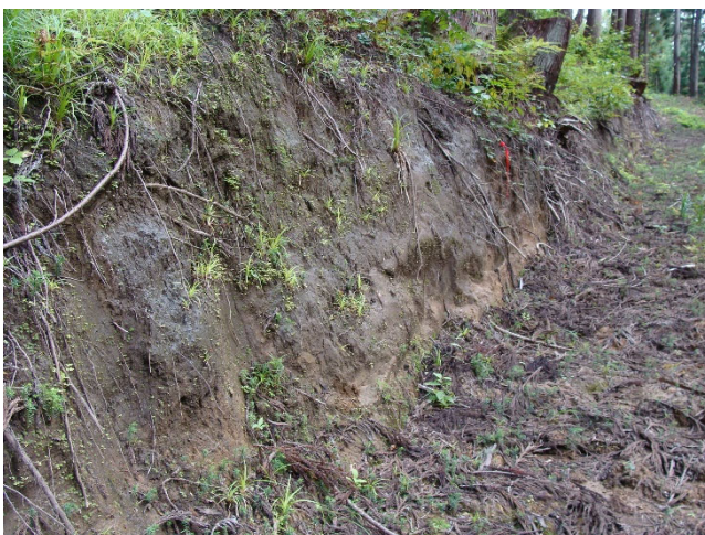
均一かつ緻密な火山灰質粘性土の切土のり面
