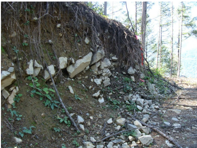
切土のり面に露出した沖積層の岩塊
