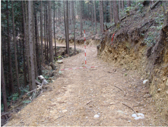
高さ 2.0m 程度の急勾配盛土の連続区間
