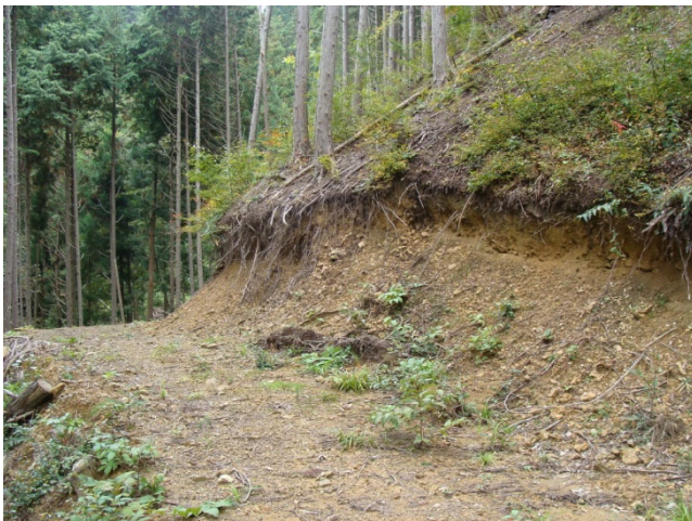
火山灰質礫質土(凝灰岩)を主体とした切土のり面
