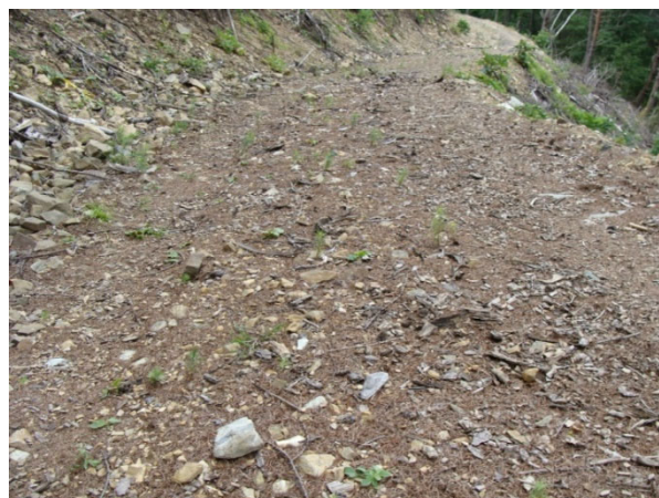
比較的締固められた盛土断面
