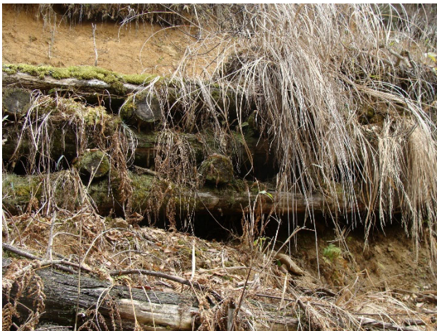
木製構造物の劣化程度の確認
