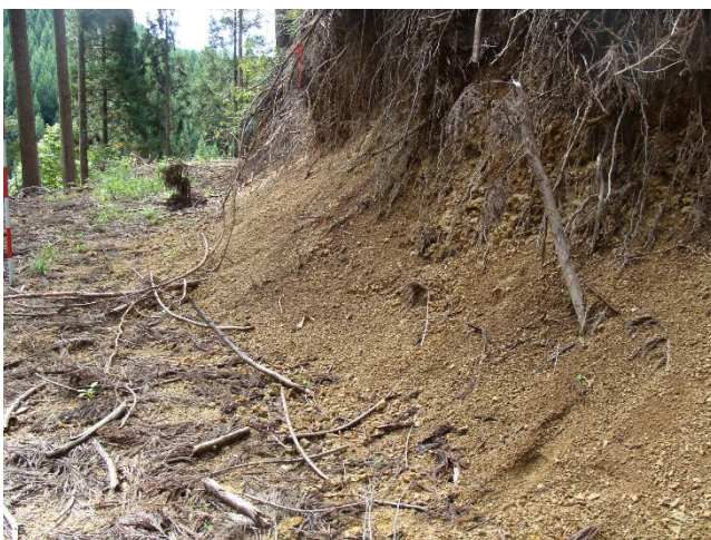
火山灰質礫質土(凝灰岩)を主体とした切土のり面
