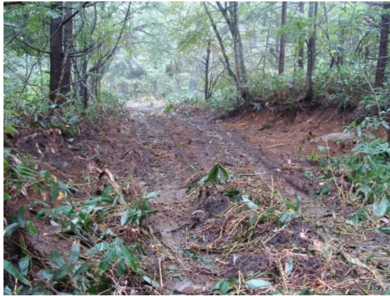
黒ボクが発達している箇所の路面の状況
