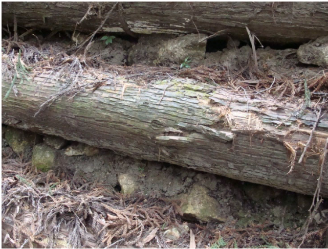
丸太組工前面に石礫を利用した一例
