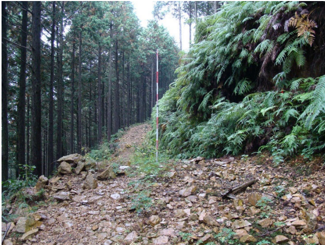
堆積岩質礫質土(砂岩)の切土のり面
