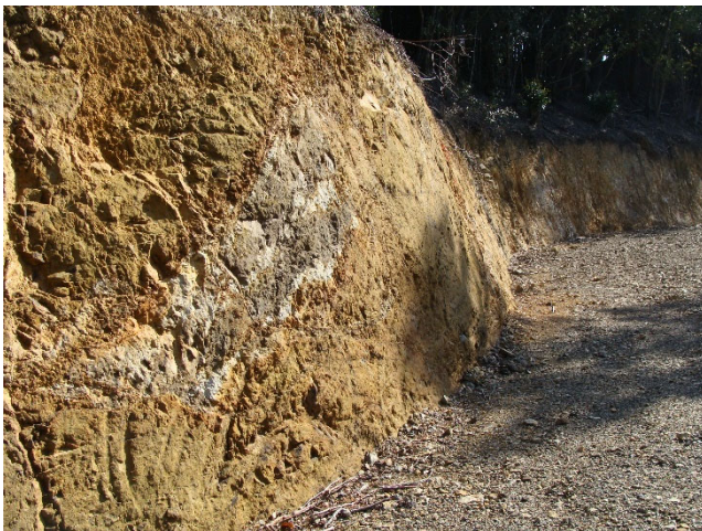
堆積岩質礫質土(砂岩・泥岩)の切土のり面
