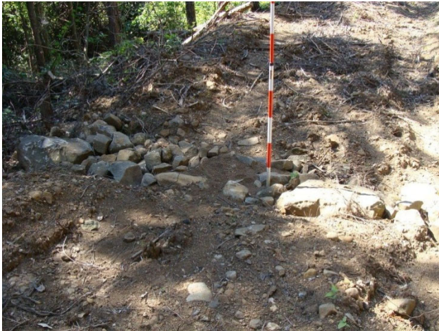
排水施設への現地発生材の利用例
