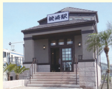
枕崎駅舎の外観
