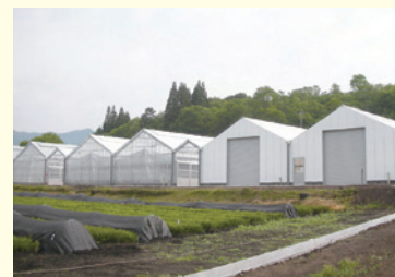
コンテナ苗生産施設の外観
