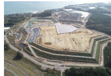
中間貯蔵施設の土壌貯蔵施設 外観(大熊町)
