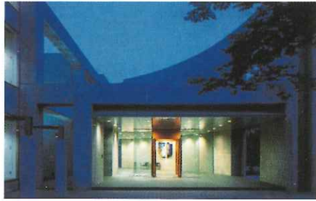
●研修センターエントランス
