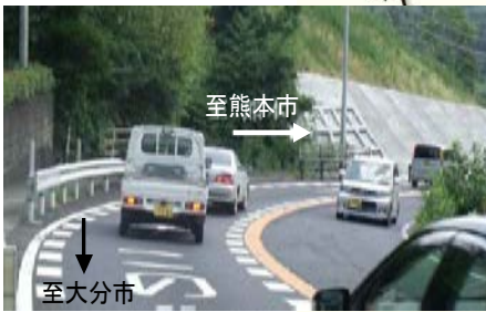
▲ 線形不良箇所【写真①】
