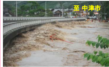
▲国道212号洞門橋
