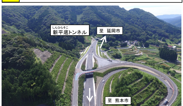
2 ひのかげふかすみ 日之影深角IC付近 進捗状況
