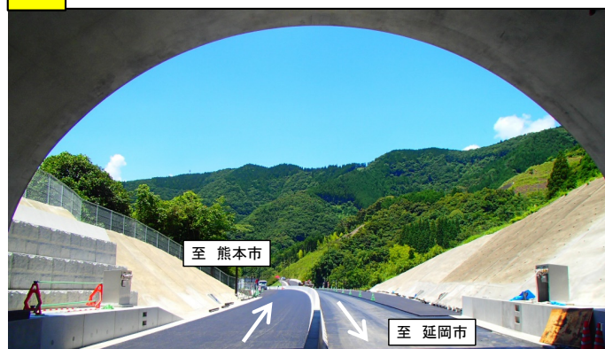
4 しんひらそこ 新平底トンネル 進捗状況
