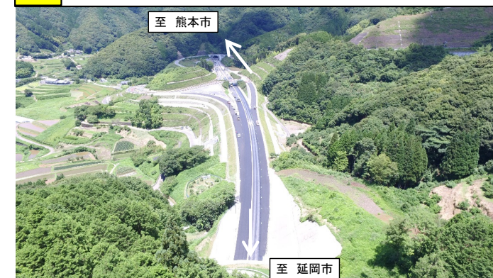
3 ひのかげふかすみ 日之影深角IC付近 進捗状況
