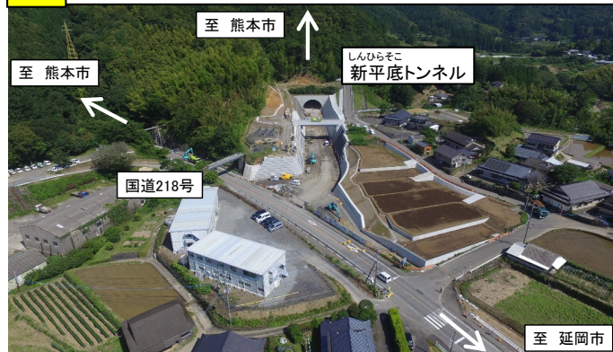
6 ひらそこ 平底交差点付近 進捗状況
