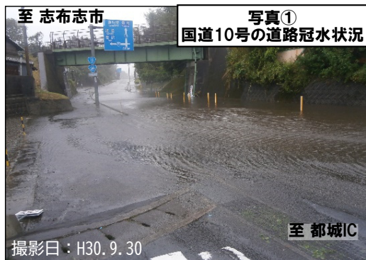
▲ 大雨による冠水状況
