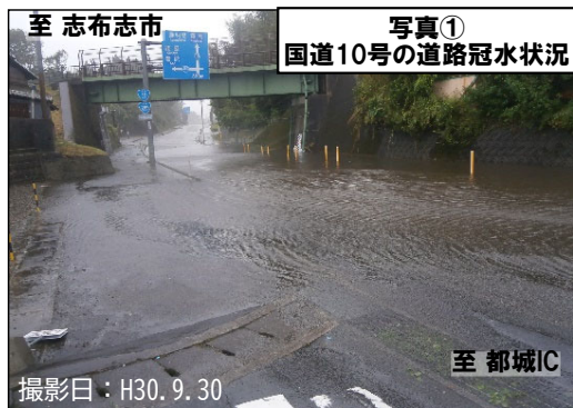
▲ 大雨による冠水状況
