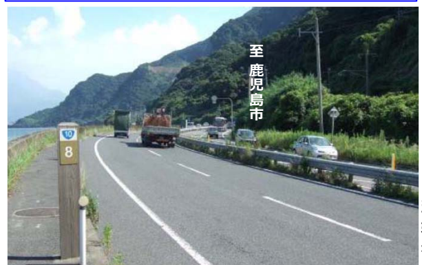
▲ 4車線開通済み区間
