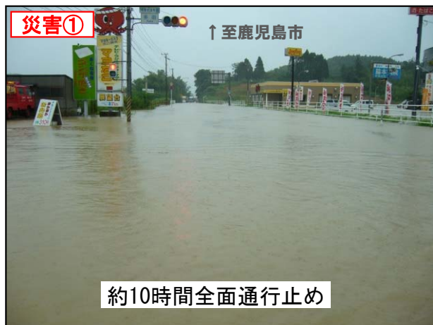
▲災害発生状況 (国道3号：阿久根市) (平成18年7月発生)
