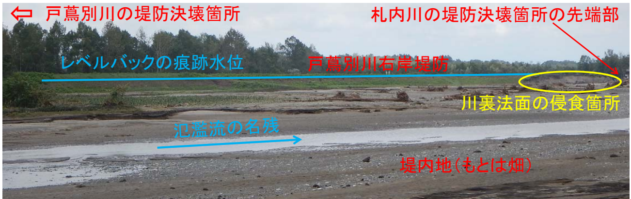
戸蔦別川からの氾濫水が流下した堤内地の状況
