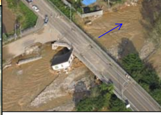
十勝川水系ペケレベツ川(被害状況) H28.9.1撮影
