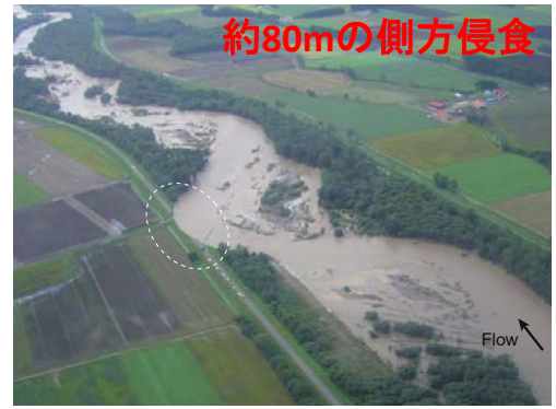
堤防流出状況(平成23年9月7日)
