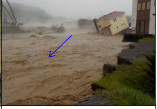
十勝川水系ペケレベツ川(被害状況) H28.8.31撮影
