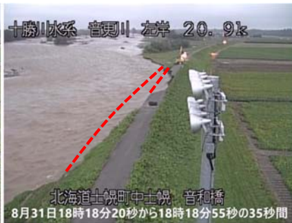
音更川の堤防決壊確認時(緊急復旧工事着手時)のCCTV画像
