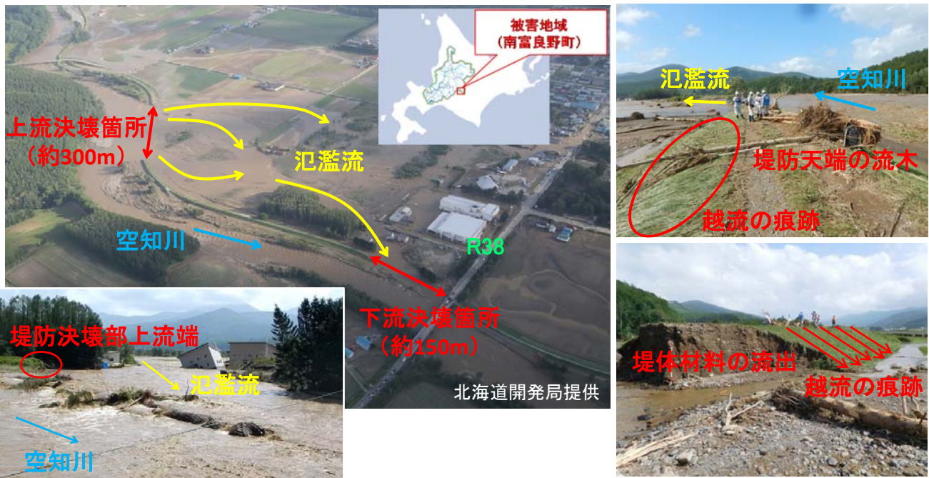
下流決壊箇所
