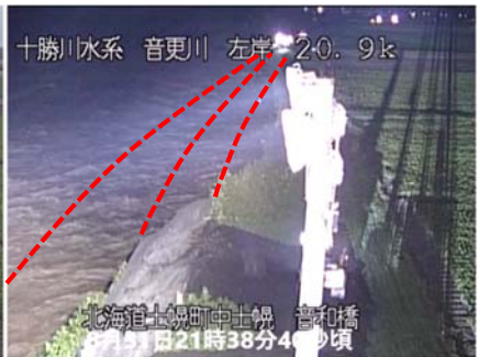
音更川の堤防決壊確認時(緊急復旧工事着手時)のCCTV画像
