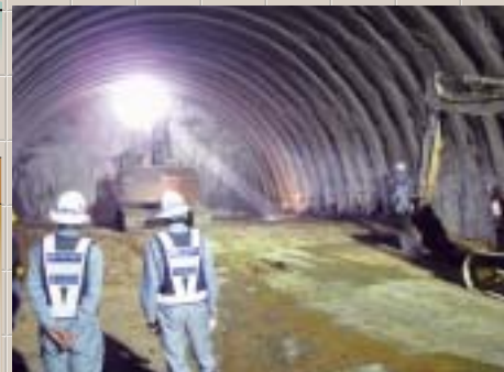
鞍掛山トンネル貫通時
