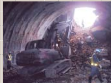
中山トンネル貫通時
