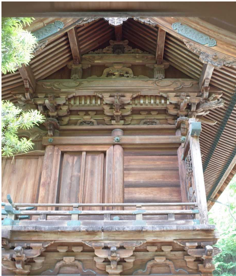
■五箇神社本殿 身舎側面
