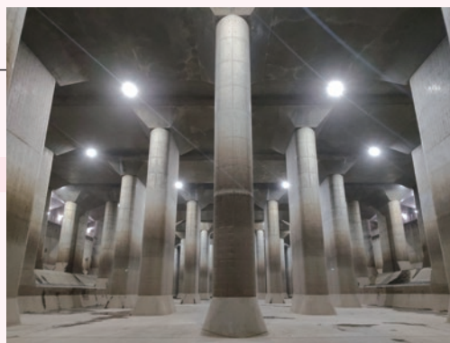
首都圏外郭放水路（春日部市）
