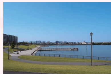
大相模調節池（越谷市）
