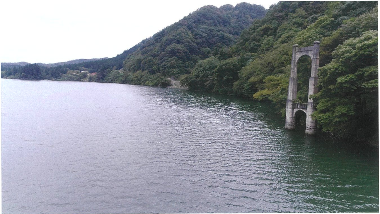
旧昭和電工(株)鹿瀬工場のために建設された吊り橋「昭和橋」の名残（阿賀町大牧）
