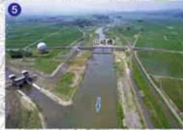
五泉市山崎地内
