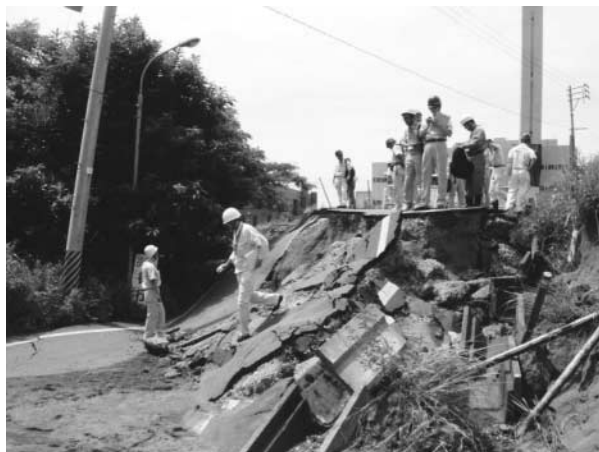
クリーンセンターかしわざきの周辺道路（水道管理設）
