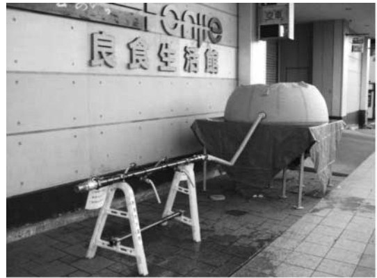
柏崎市内の応急仮設共同給水栓 (平成19年7月23日)
