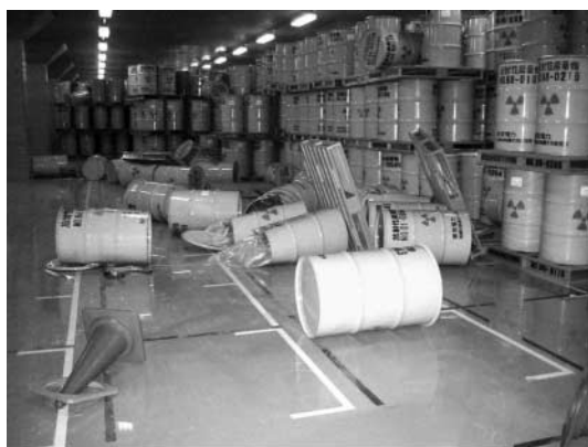
固体廃棄物貯蔵庫内の状況
