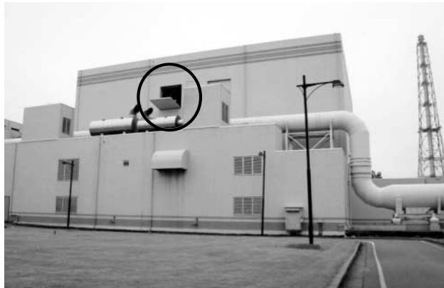
3号機原子炉建屋のブローアウトパネルの状況
