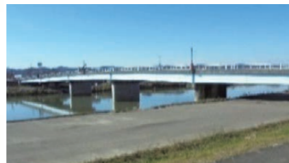
稲田橋【昭和62年(西暦1987年)竣工】
