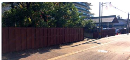
既存塀やフェンスの茶塀化
