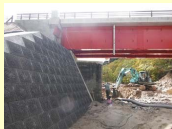
赤い部分が新しい金泉橋。その下には旧金泉橋の橋台が見えます。
