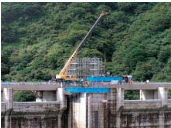
取水設備据付状況 (取水設備架台)
