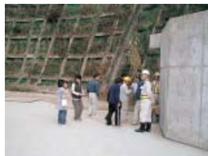
左岸側からダムの内部を見学
