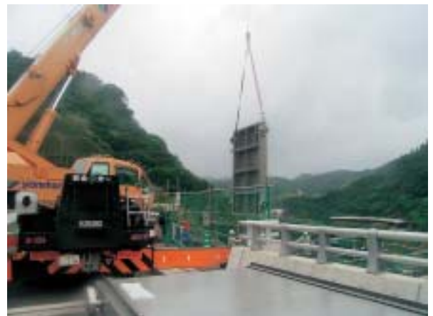
取水設備据付状況 (取水ゲート扉体)
