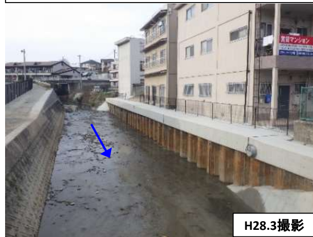
②生駒工区（改修済み区間）
