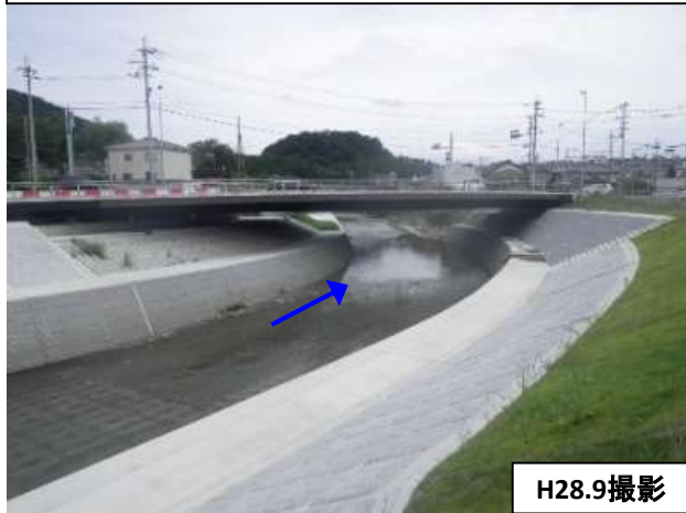
①斑鳩工区（改修済み）
