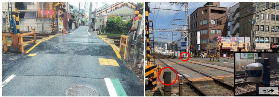
事故が発生した踏切
