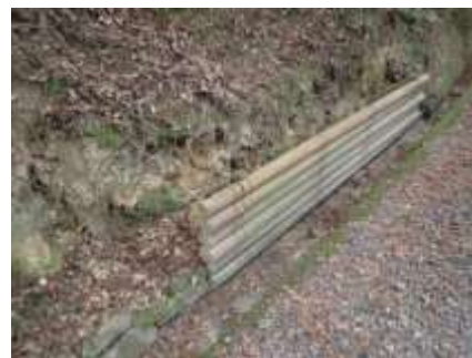
図7 木製の土留め（例） （春日山遊歩道で使用されているもの）
