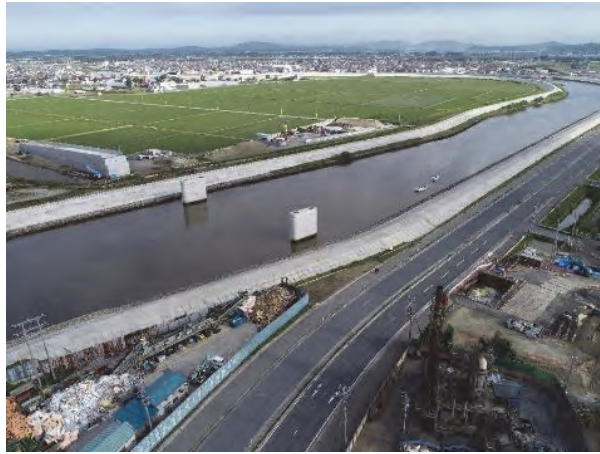
定川復興大橋架設前
