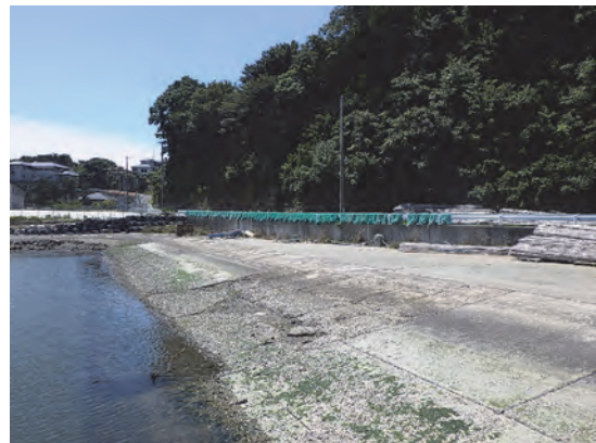
代ヶ崎船だまり（A）物揚場
