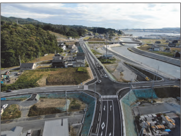
東八幡前地区
