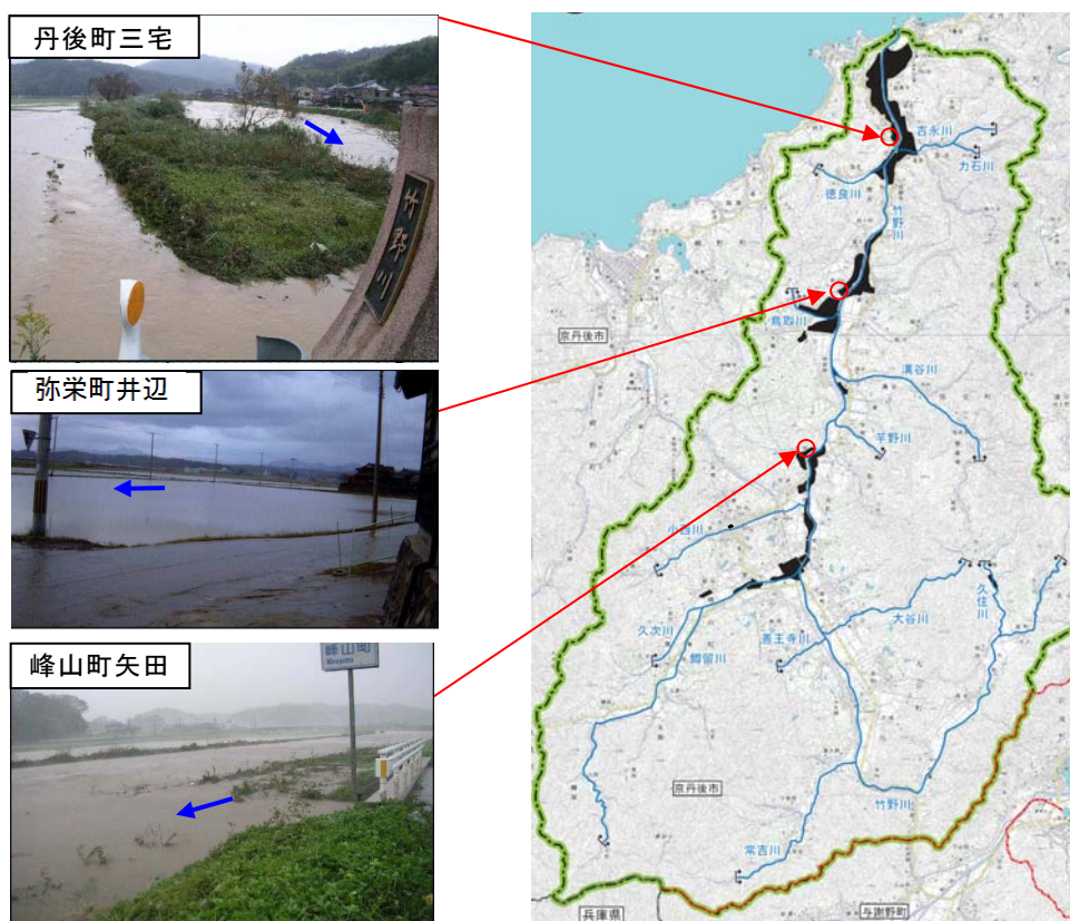
図 1-6 浸水被害の状況（竹野川、平成16年10月洪水）
