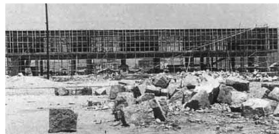
建設中の陳列館(昭和27[1952]年7月1日撮影) (提供:広島市公文書館)
