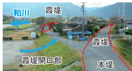
④ 霞堤開口部
