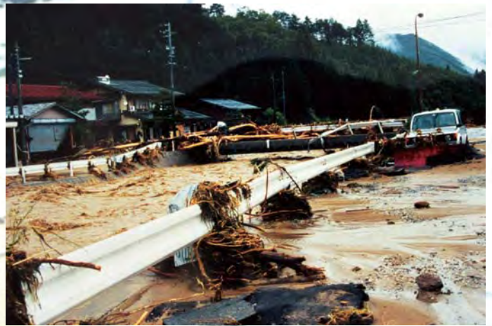
かせんとのかわ しんすいじょうきょう 急流河川殿川における浸水状況 ひだしふるかわちやうのぶか (飛騨市古川町信包・平成11年9月)
