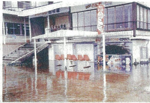
猪苗代湖湖畔の被害状況 (平成10年8月末洪水)
