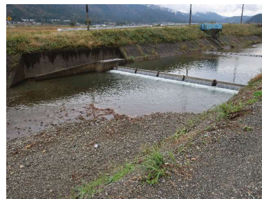
はす川に設置されている取水堰
