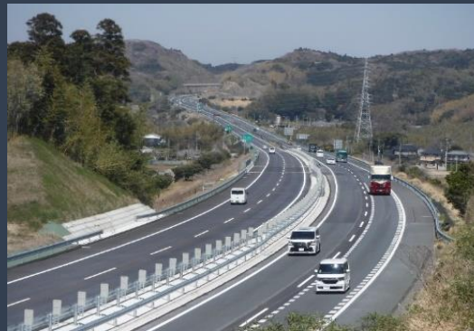
館山自動車道（君津～富津中央間）
