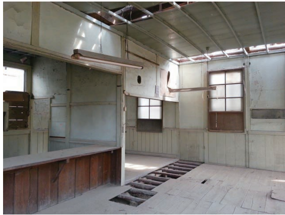
図6 再生前局舎内装
