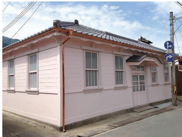
図5 再生直後の局舎
