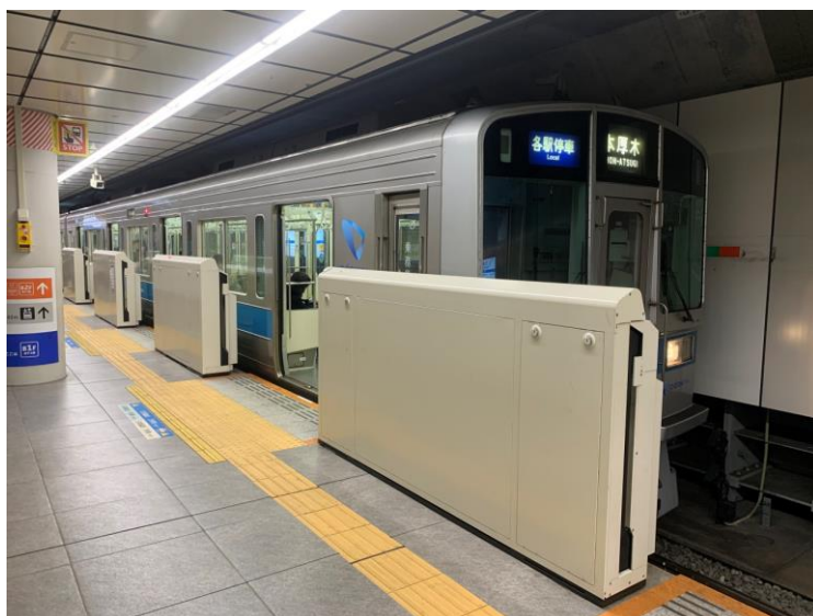
下北沢駅地下1階ホームドア
