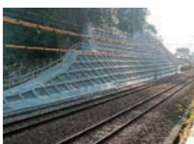
法面防護工事
