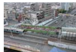
環状7号線との立体交差化工事
