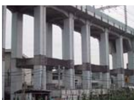
高架橋の耐震補強工事
