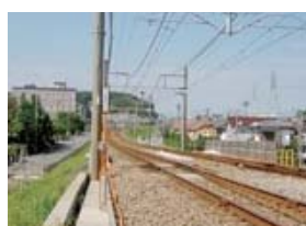
土砂崩壊検知システム
