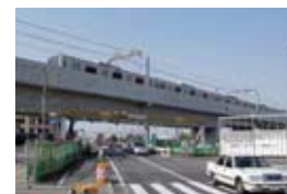
2007 年に高架化工事を完了
