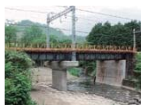
橋梁の耐震補強工事
