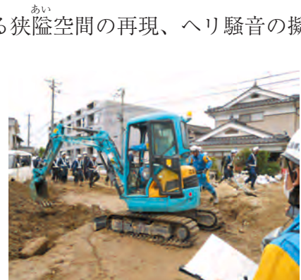
重機の出動状況
