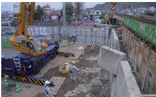
写真-3 擁壁分割撤去状況
