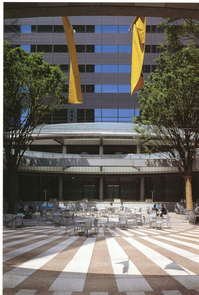
地下1階の円形サンクンパティオ Circular sunken patio.
