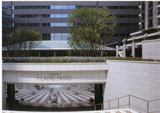
サンクンパティオへの入口 Entrance to the sunken patio.
