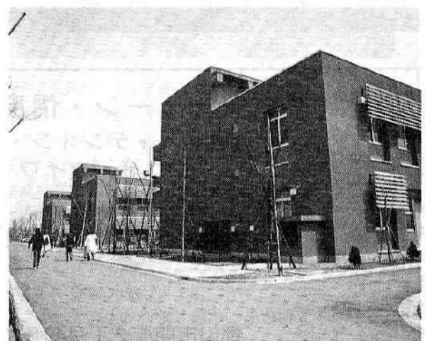
昭和54年7月完成の新実験棟
