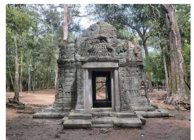
解体修復を完了したタネイ寺院東門 (カンボジア)
