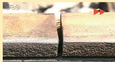
「電車のレールのすきま」
